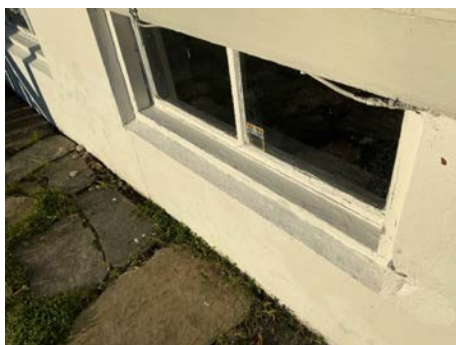
Eldre vinduer i kjeller.
