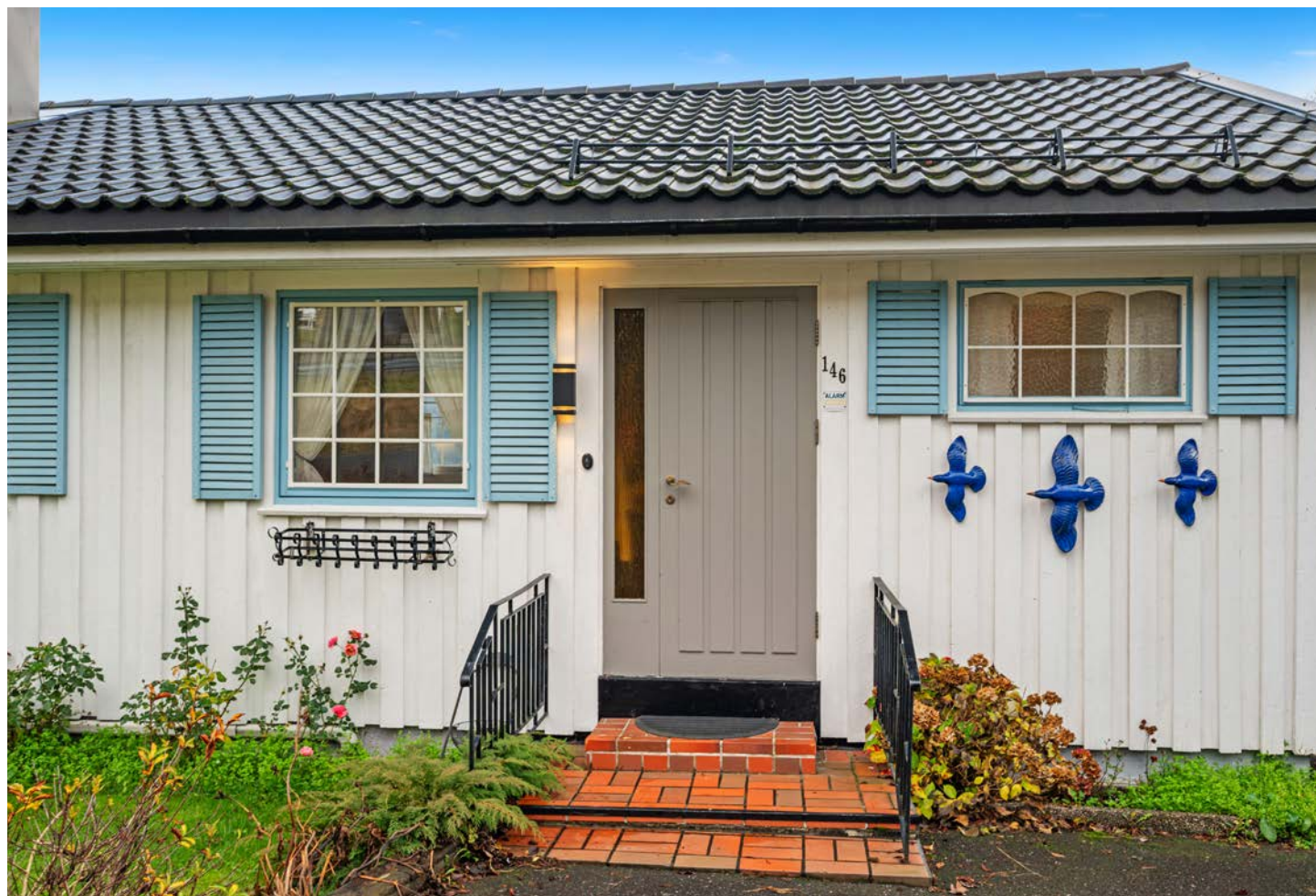
Inngangspartiet til 1. etasje
