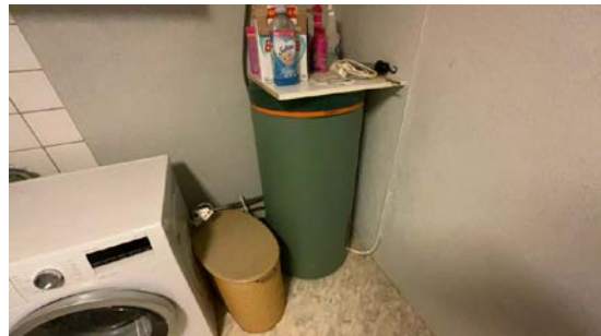
Varmtvannstank.
