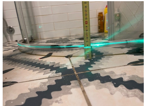
Motfall mot dør på ca. 5 mm
