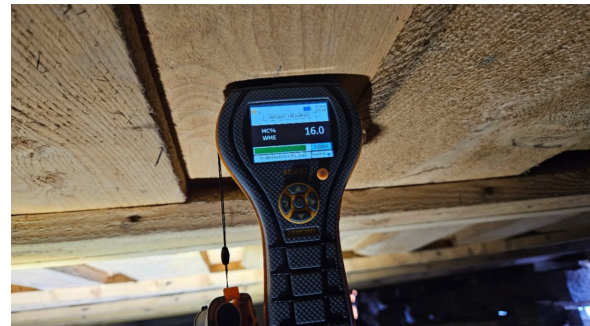
Ingen unormale fuktverdier ble registrert ved befarings
