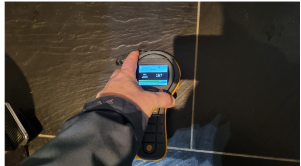
Det ble fuktmålt ved revisjon, ingen unormale fuktverdier ble registrert.
