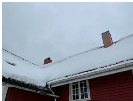
Takflater snødekt ved befaringen.
