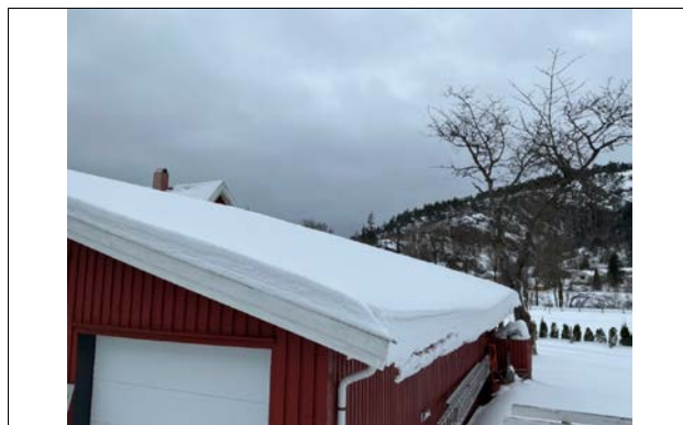
Snødekte takflater ved befaringen
