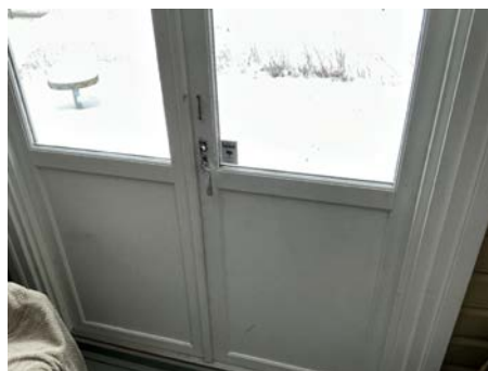
Dobbelfløyet dør med isolerglass fra slutten av 1990 tallet
