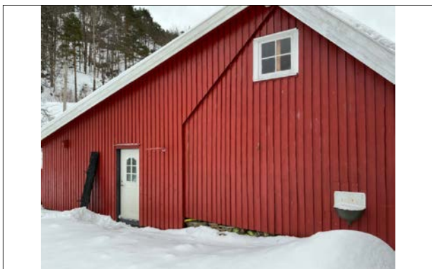
Endevegg hvor man kan se skille mellom eldre og nyere del
