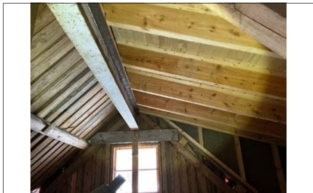
Uinnredet loftsdel. Delvis ombygd takkonstruksjon. Det er ikke fremlagt dokumentasjon på utførelsen, men eier opplyste at arbeider er utført av firma/fagfolk
