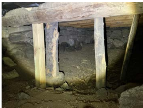
Krypkjeller under kjøkken. Kontrollert fra luke i vegg
