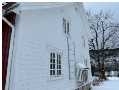
Nordvegg fra 2024. Etterisolert og vindtetting.
