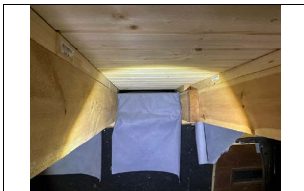
Synlig luftespalte etablert i takkonstruksjon over garasjeedel
