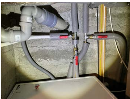
Variierende alder på røropplegg
