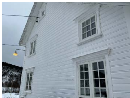
Sydvegg oppgradert i 2016
