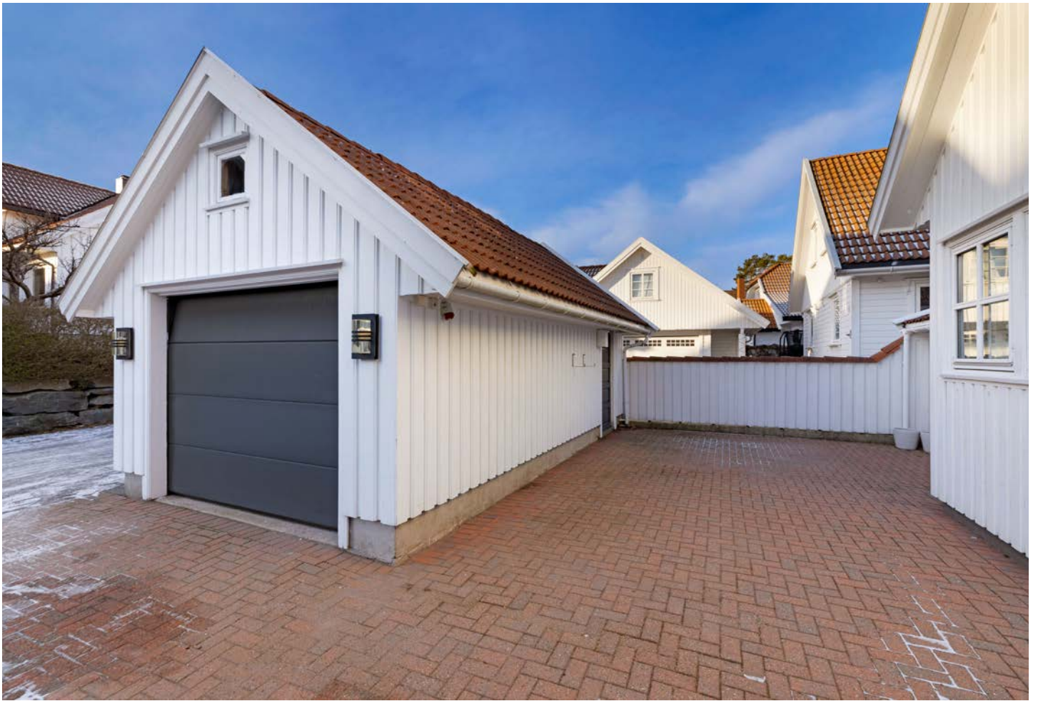
Garasje og parkeringsplasser på tomt. El. lader montert.
