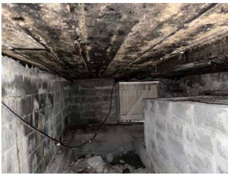
Krypkjeller er trang inn mot sørvest side. Høy fuktighet i treverk.
