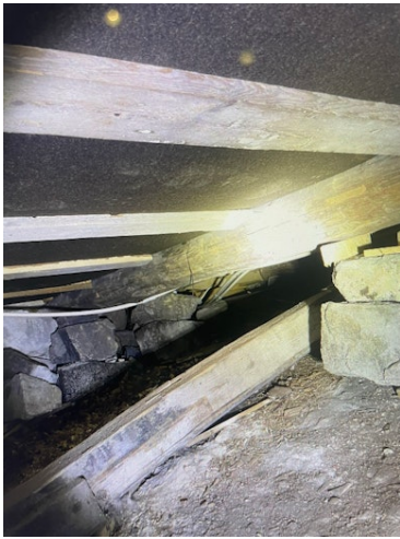
Krypkjeller er trang inn mot sørvest side. Høy fuktighet i treverk.
