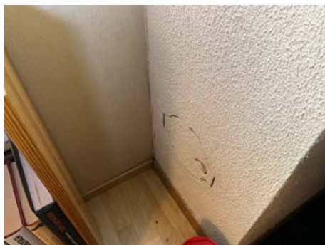
Foto viser feieluke for nært brennbart materiale.
