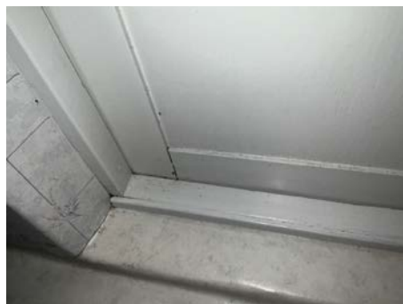
TG 2 Balkonger, terrasser og rom under balkonger
