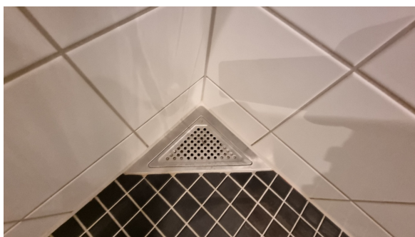
Kontroll av sluk.
