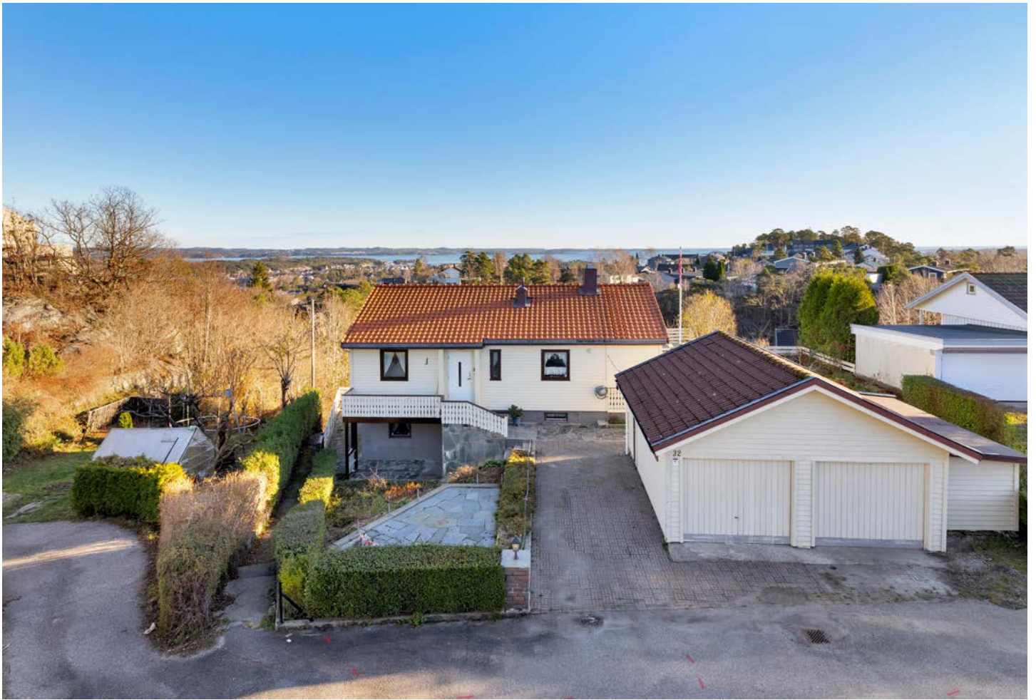
Boligen har en usjenert og rolig beliggenhet i et veletablert boligstrøk i Voiebyen, Ytre Vågsbygd i blindvei med lite trafikk.
