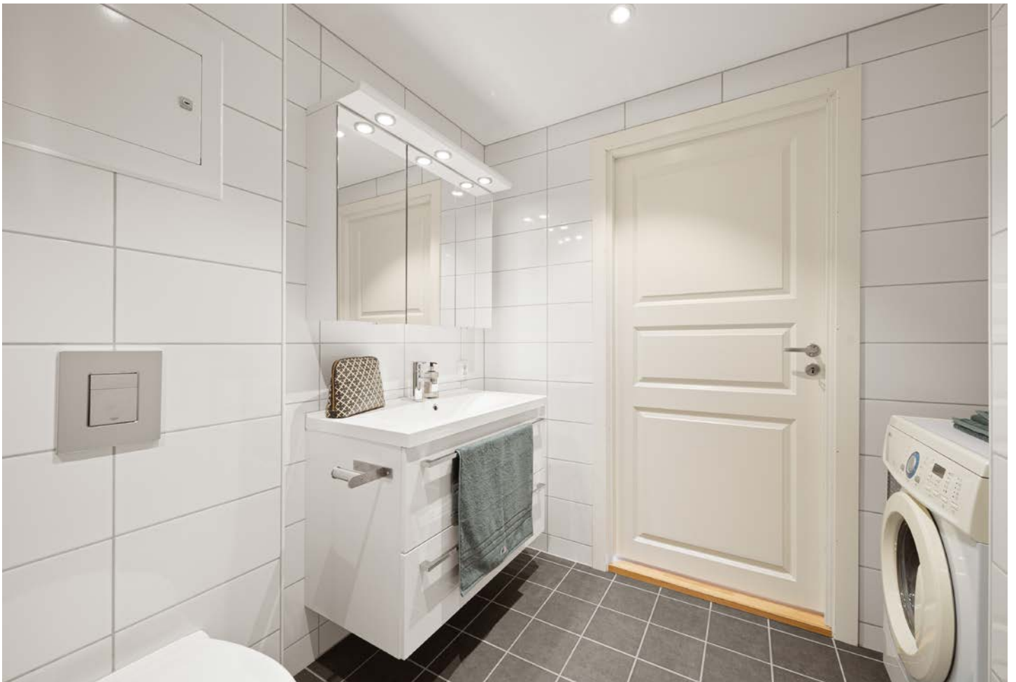
Det er termostatstyrte varmekabler i gulv.
