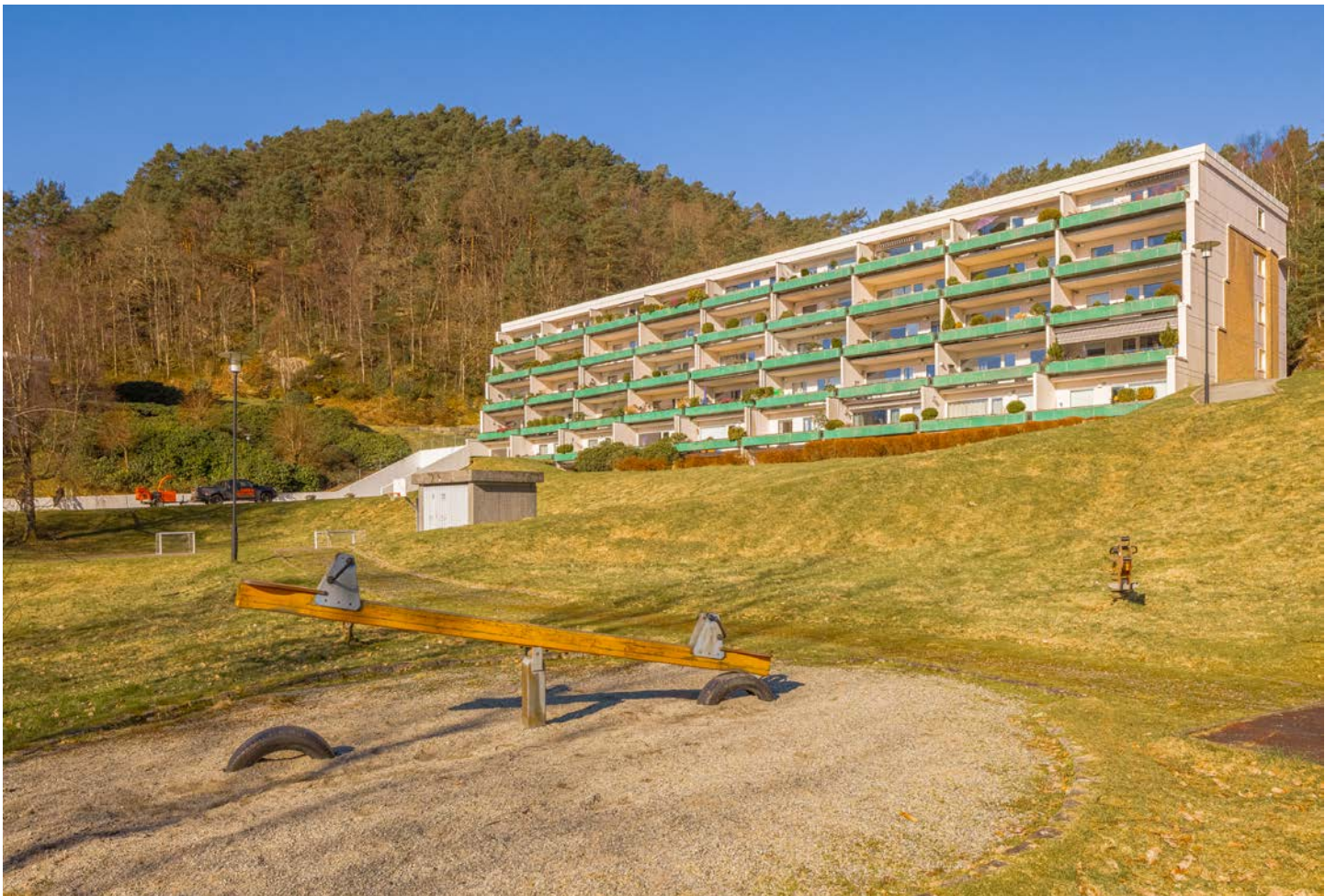
Flott opparbeidet fellesareal i borettslaget med lekeplass, ballbane m.m.
