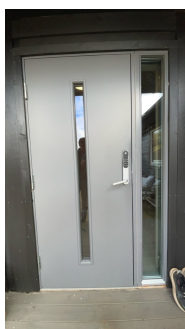
Manglende beslag og malingslitt karm på balkongdøren i soverom.
