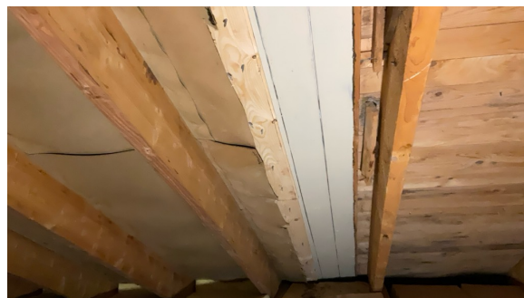
Overgang mellom opprinnelig del og tilbygg over stue.
