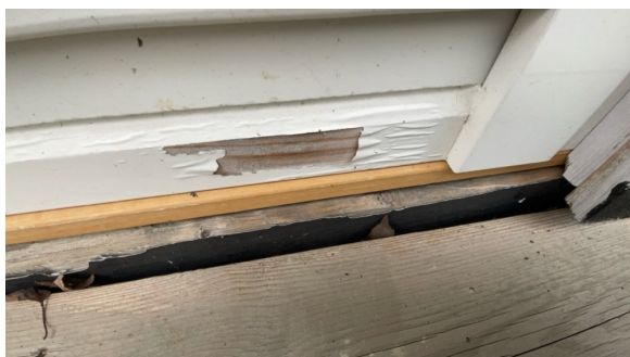
Manglende beslag og malingslitt karm på balkongdøren i soverom.
