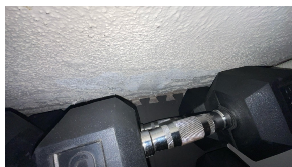
Saltutslag på grunnmur innvendig i boligen.
