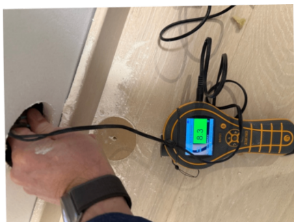
Fuktmåling i vegg med pigg.
