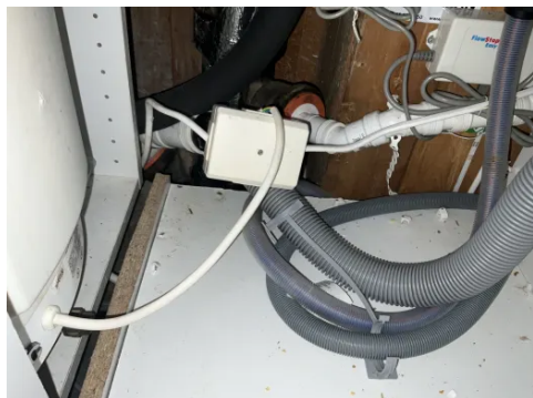
Løse ledninger/koblingspunkt.
