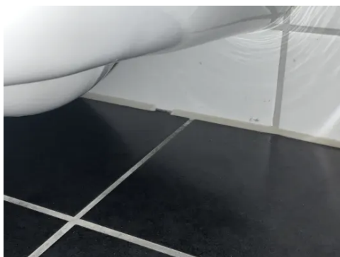
Mindre/svak spalteåpning under toalett.
